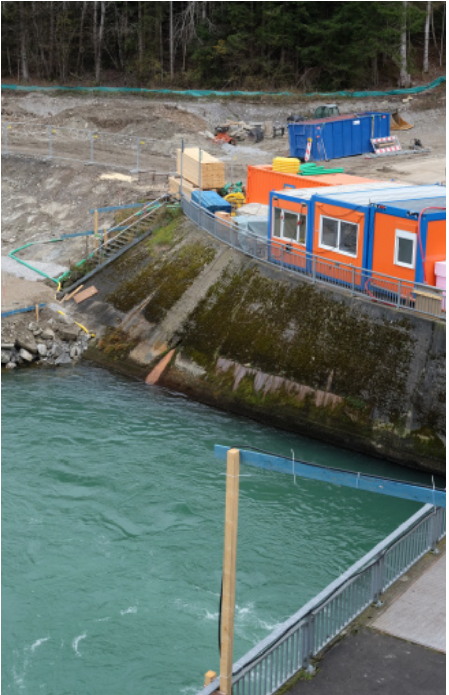
Baustelle einer Fischaufstiegsanlage an der Staustufe Dessau am bayerischen Lech.
