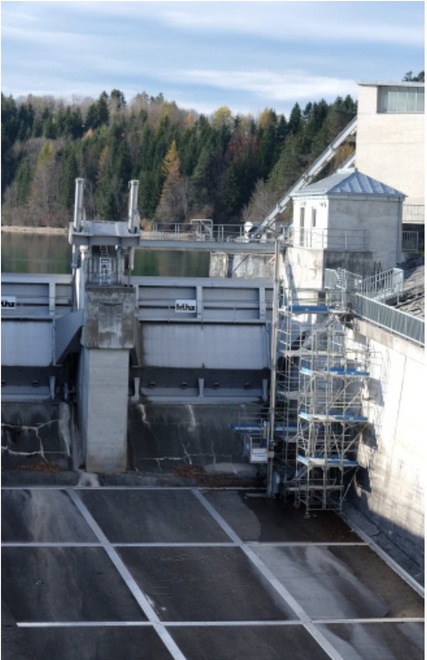
Links: Die Litzauer Schleife ist einer der wenigen unverbauten Abschnitte des Lechs. Rechts: Hochwasserüberlauf am Förgensee-Damm
