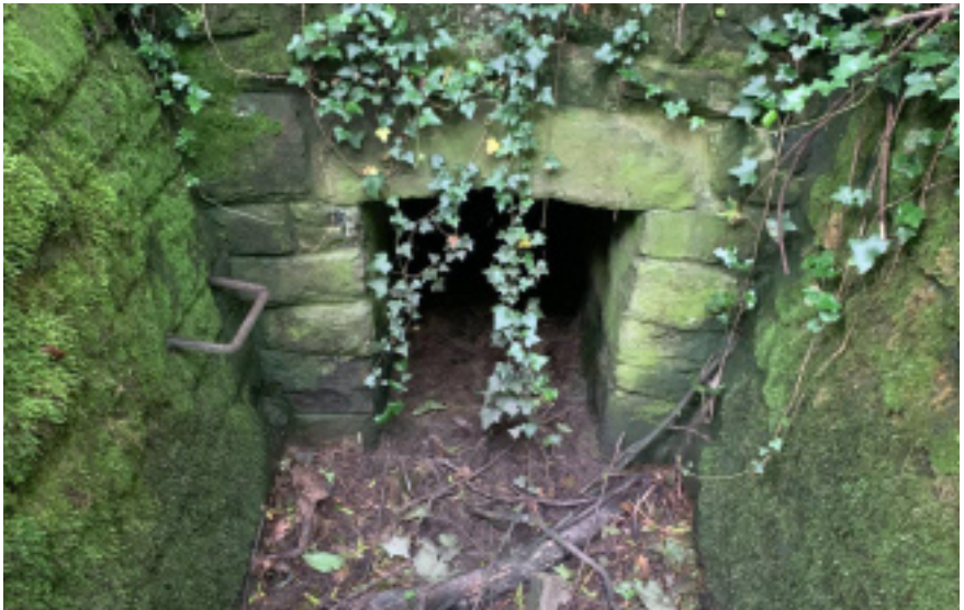
Ottakringer Bach, Quelle am Gallitzinberg
